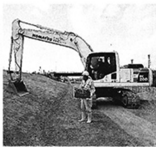
協栄建設が堤防強化工事で活用したシヨベルカー。3Dの地形データに基づいて施工の精度を高める機器が搭載されている
